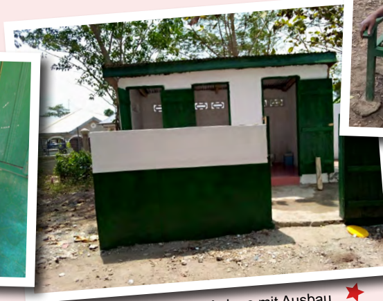
Erweiterung der sanitären Anlage mit Ausbau der Frischwasserzufuhr
